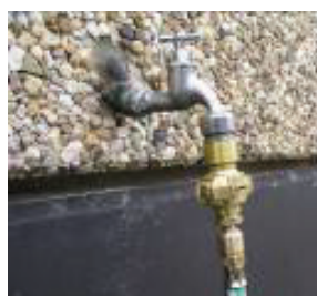
Overgangsstykke nippel/bajo med lufttilførselsslange
